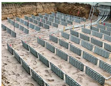
Verlegebeispiel im Komplett-Aushub (auch im Grabenaushub möglich)
